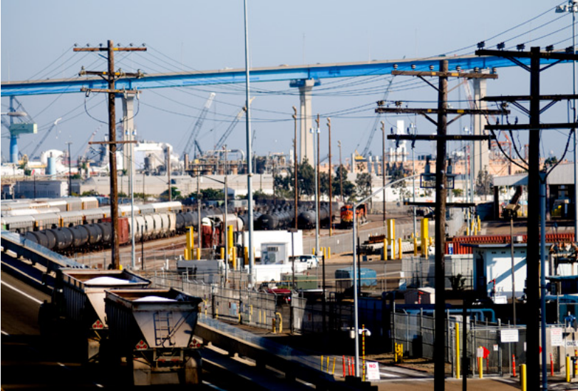
Puente Coronado desde Barrio Logan: Crédito fotográfico voiceofsandiego.org
