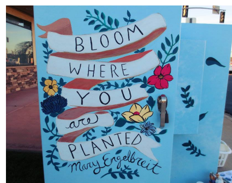
Caja eléctrica en El Cajón, CA. Crédito fotográfico: HHSa Región Este.
